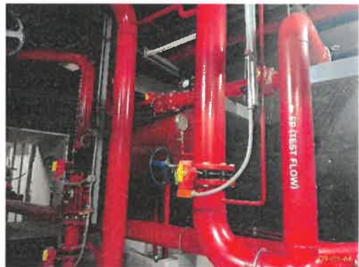
ระบบน้ำสำรองดับเพลิง และระบบจ่ายน้ำดับเพลิง
