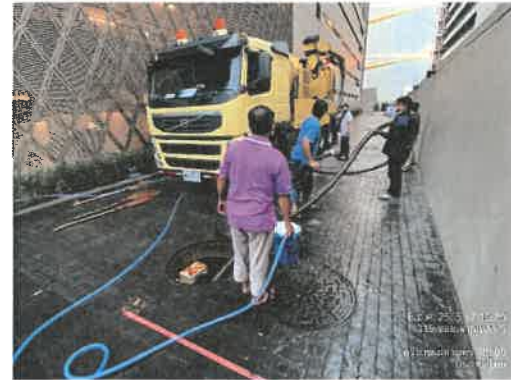
ภาพที่ 2.2-12 สูบตะกอน และตัดไขมัน ระบบบำบัดน้ำเสีย
