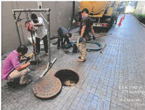
ภาพที่ 2.2-12 สูบตะกอน และตัดไขมัน ระบบบำบัดน้ำเสีย
