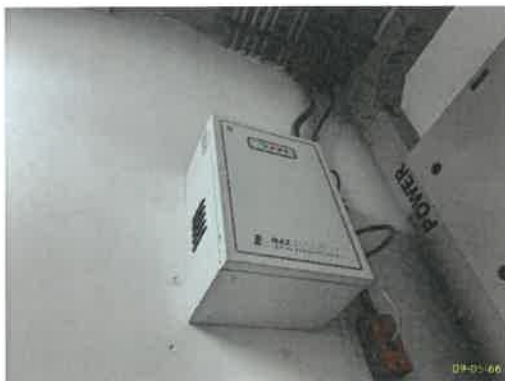
ระบบป้องกันอันตรายจากการเกิดไฟฟ้ารั่วและฟ้าผ่า ภาพที่ 2.2-21 (ต่อ) ระบบไฟฟ้า
